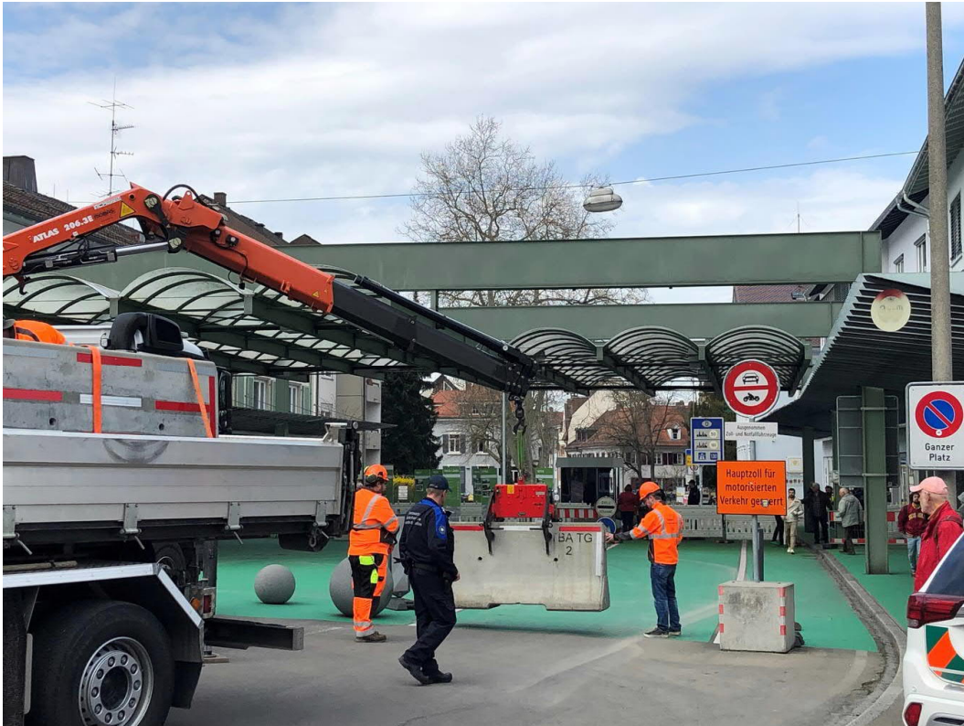
Das kantonale Tiefbauamt rückt an
