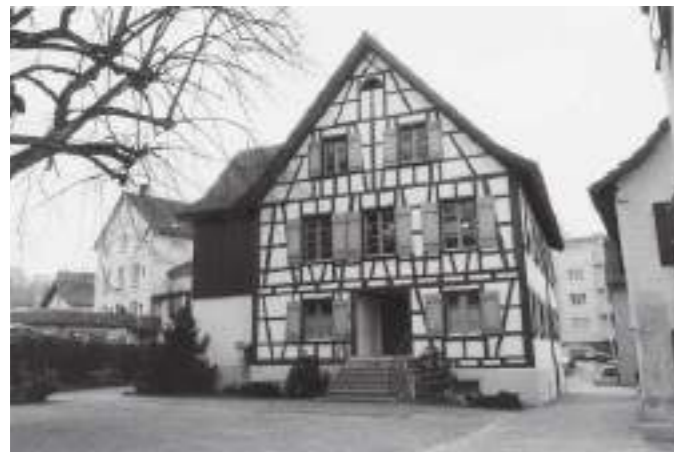
Ehemaliges Gemeindehaus Kreuzlingen in Holzbau
