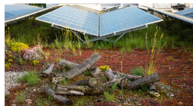
Strukturvielfalt auf einem Energiegründach
