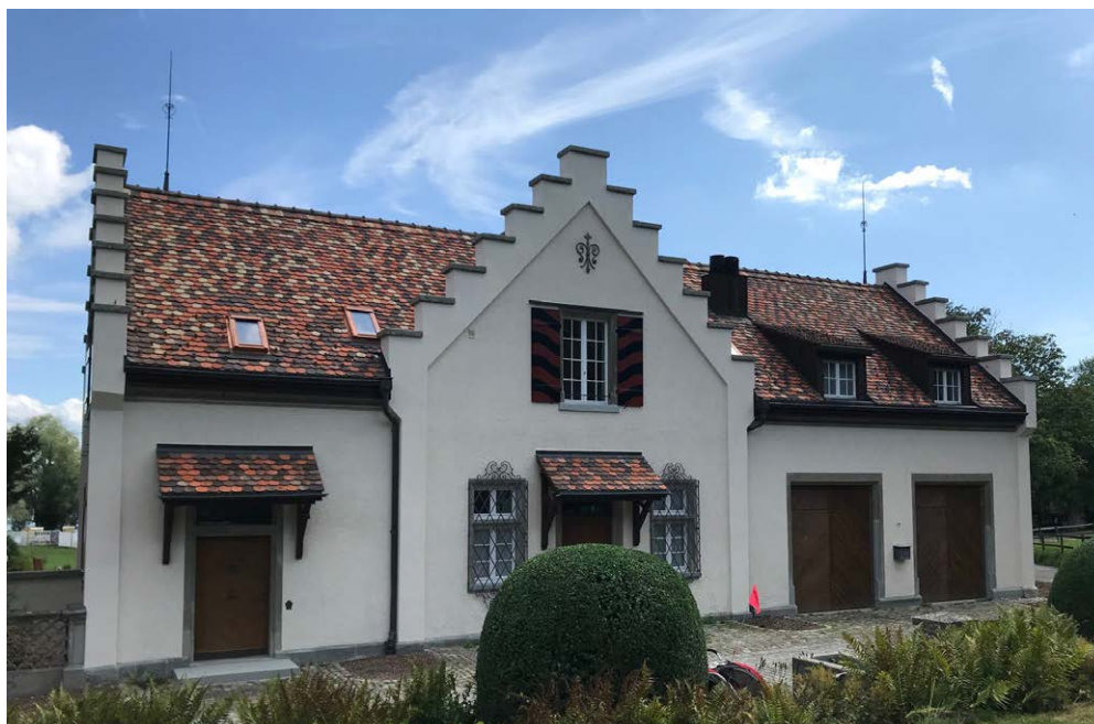
Sanierte Remise bei der Seeburg.
