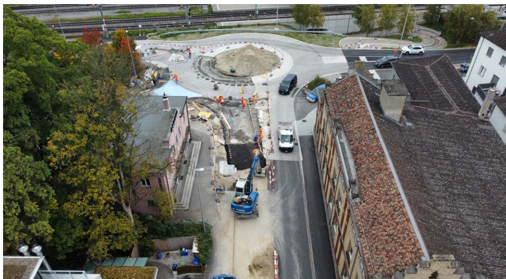
Die Sanierung des Emmishoferkreisels.
