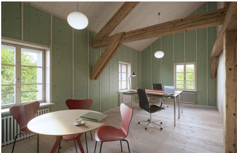
Haus Sallmann, Innenansicht Generalplanerteam Ryf Scherrer Ruckstuhl Architekten
