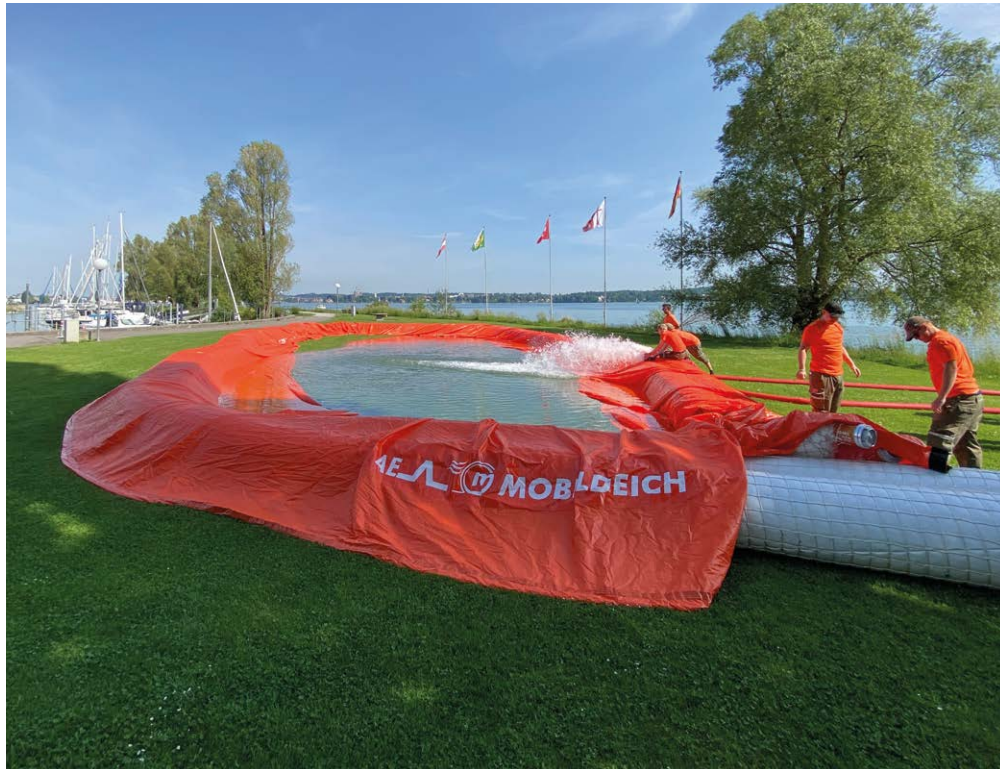
Mobiler Hochwasserschutz-Damm.
