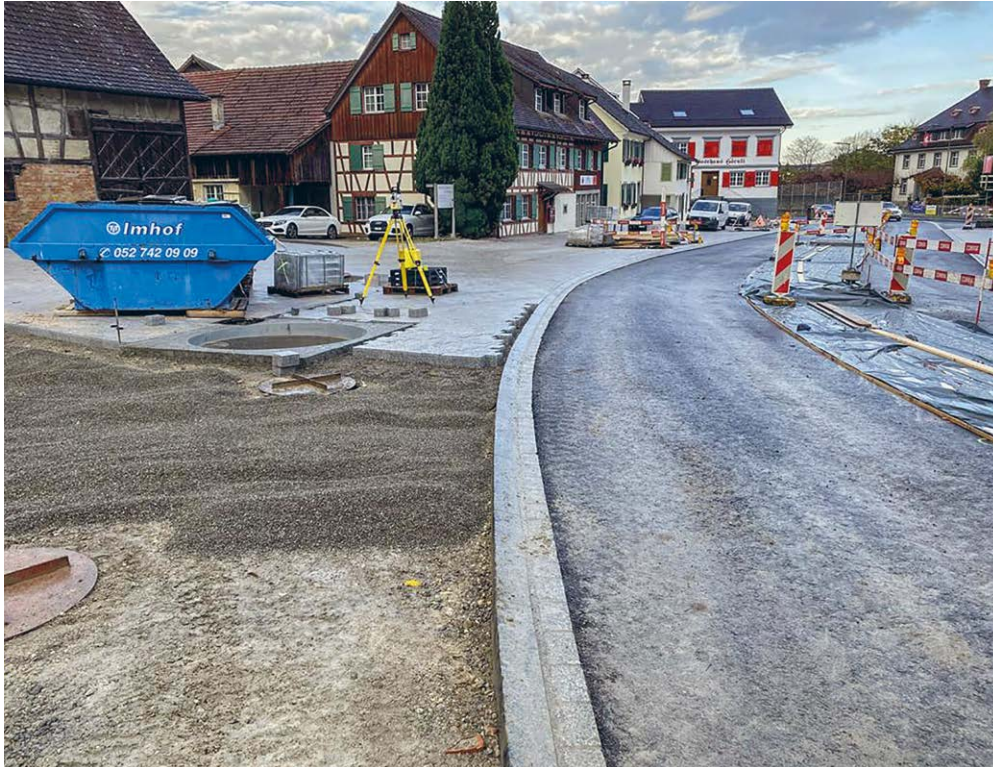
Pflasterungsarbeiten im neugestalteten Dorfkern von Kurzrickenbach.
