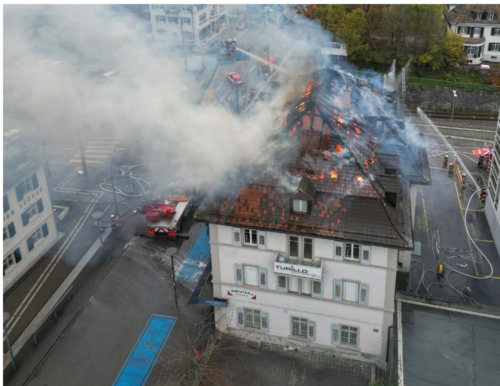
Dachstockbrand Haus Helvetia an der Hauptstrasse.
